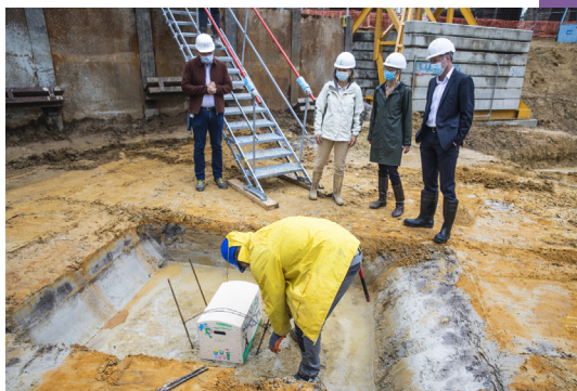
Pose de la première pierre
